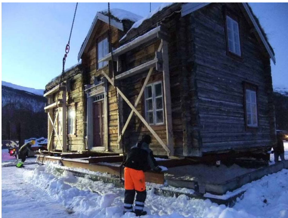
Foto: NTRM. Sokkelvikhuset får nytt fundament
